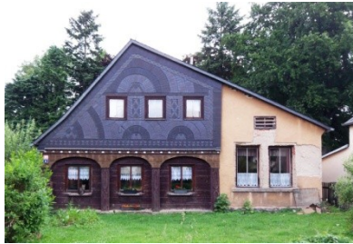
Abb. B-160, Abb. B-161 Hauserweiterungen mit Pferdekopfdach in Rumburk und Leutersdorf
