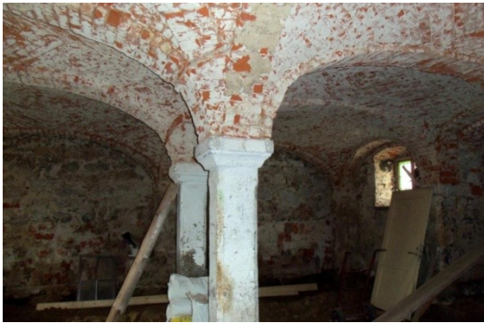
Abb. B-133 Gewölberaum mit mehreren von Säulen getragenen böhmischen Kappen
