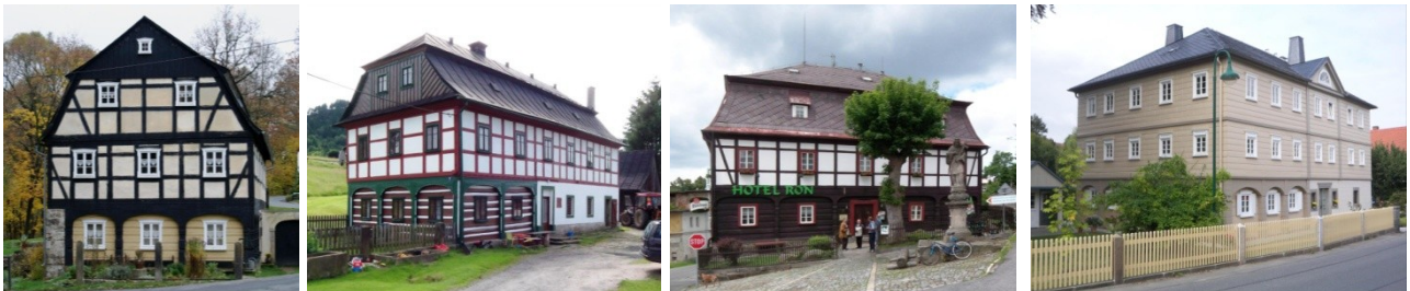
Abb. B-153 Mansarddach, Schirgiswalde / Abb. B-154 Krüppelwalmmansarddach, Vysoká Lída / Abb. B-155 Walmmansarddach, Mikulášovice / Abb. B-156 Walmdach, Niedercunnersdorf
