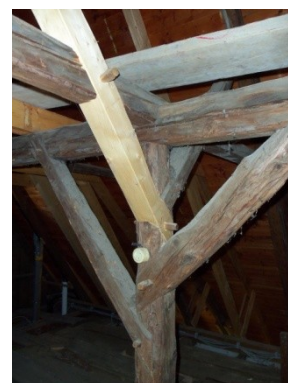
Abb. B-174 Konstruktionsknoten an einer Firstsäule mit zahlreichen Spuren ausgebauter Teile / Abb. B-175 reparierter Konstruktionsknoten
