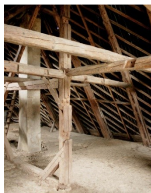
Abb. B-174 Konstruktionsknoten an einer Firstsäule mit zahlreichen Spuren ausgebauter Teile / Abb. B-175 reparierter Konstruktionsknoten
