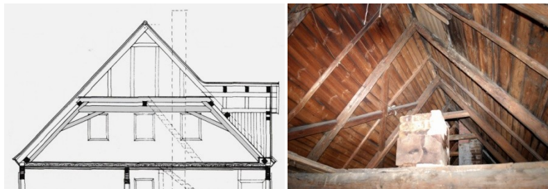
Abb. B-171 Aufmaß liegender Dachstuhl, Cunewalde / Abb. B-172 Strecklaten zwischen den Sparren zur Unterstützung der Dachschalung für die bessere Nagelbarkeit einer Schieferdeckung (Foto: St. Freitag)
