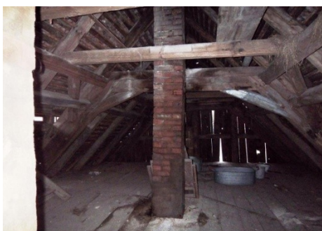
Abb. B-173 (Gruppe): Reiterdachstuhl / Kehlbalkendach mit Windrispen / Kehlbalkendach mit doppelt stehendem Stuhl, Pfette oberhalb des Kehlbalkens, mit Kopfbändern / Kehlbalkendach mit doppelt liegendem Stuhl, mit Spannriegel und Kopfstreben
