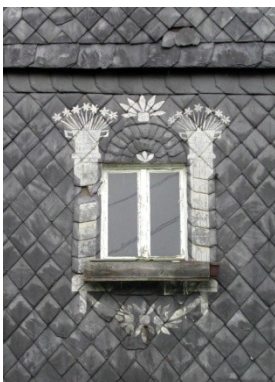
Abb. C-84 links: aufgemaltes freies Muster als Fensterumrahmung (Sohlandl)/ Mitte und rechts: Vergleich der Mustergestaltung mit Kunstplatten (Wehrsdorf) und Naturschiefer (Sebnitz)
