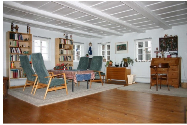
Abb. C-109 wieder hergestellte Holz­sichtigkeit an Wand und Decke und Erneuerung des hellen Anstriches
