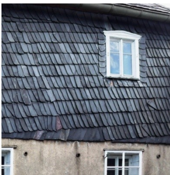
Abb. C-86 links: altdeutscher Behang in Weifa/ Mitte und rechts: Rechteckschablonendeckungen in Neukirch/L. und Vlčí hora
