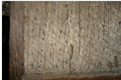
Abb. C-112: links: „1781“: auf dem Kopf (?) stehender Bauzeitvermerk, bei der Präsentation als Foto dazu geheftet /Mitte und rechts: Kamm- oder Finngemuster im Lehmverstrich, gekalkt
