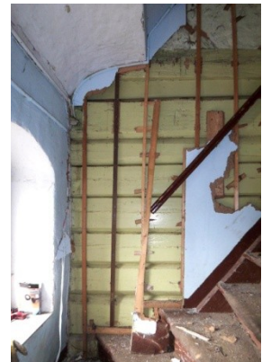
Abb. C-107 Kassetten bemalt im Faktorenhaus / Abbau junger Verkleidungen durch den neuen Hauseigentümer: sogar Schiebeläden (mundartlich „Ritschel“) kommen zum Vorschein!
