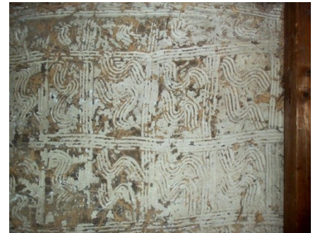
Abb. C-112: links: „1781“: auf dem Kopf (?) stehender Bauzeitvermerk, bei der Präsentation als Foto dazu geheftet /Mitte und rechts: Kamm- oder Finngemuster im Lehmverstrich, gekalkt
