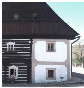
Abb. C-54 Kellenrückenputz, Granitgewände / Putzbänder in Malá Skála
