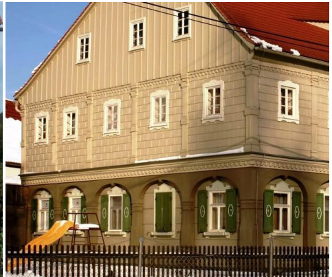
Abb. C-76 Vertäfelung der Obergeschosse (profilierter Umgebinderstander unverkleidet): links: Eibau (+) / Mitte: Oderwitz/ rechts: Leutersdorf
