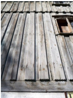
Abb. C-66 Kriecher-Decker-Schalung im OG, Deckleistenschalung im DG (Großröhrsdorf)
