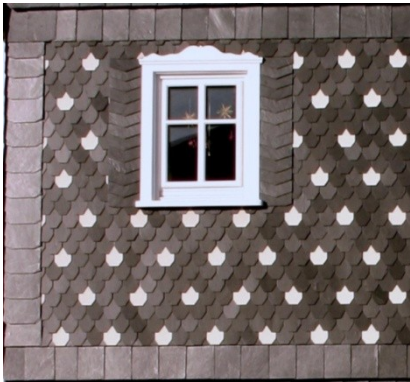
Abb. C-85 Wabenschablonendeckung mit 1/9tel Aufhellung durch weiße Kunststoffschablonen/ Mitte: Kreuz, Herz und Anker in einem Wabenbehang/ rechts: Schuppenschablonendeckung (Zeichnung: BWB Manuskript Neuauflage, Vojtisek)
