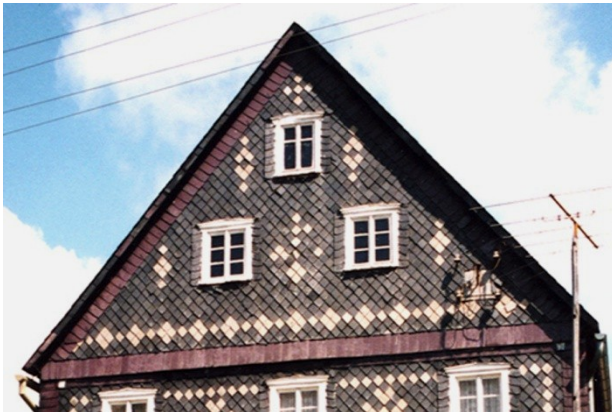
Abb. C-93 Vergleich zwischen einem regionaltypischen traditionellen Schieferbehang und einem jüngst ausgeführten Giebelbehang
