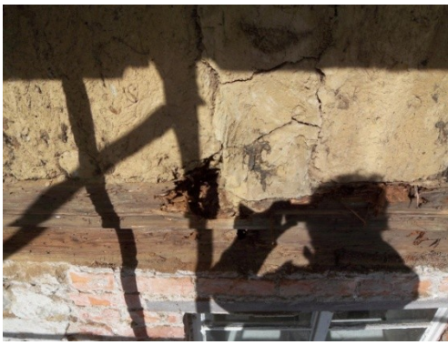
Abb. C-79 Inspektion der freigelegten Fachwerkfassade
