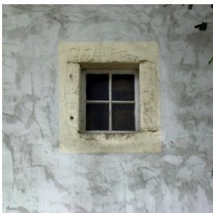
Abb. C-54 Kellenrückenputz, Granitgewände / Putzbänder in Malá Skála
