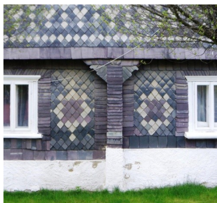
Abb. C-87 links: „Eternit“-Behang aus großformatigen Platten mit Anstrich (Vlčí hora)/ rechts: grobes Erscheinungsbild durch großformatige „Eternit“-Platten
