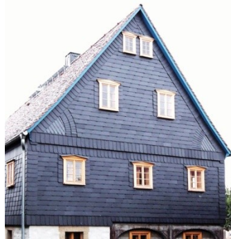
Abb. C-86 links: altdeutscher Behang in Weifa/ Mitte und rechts: Rechteckschablonendeckungen in Neukirch/L. und Vlčí hora
