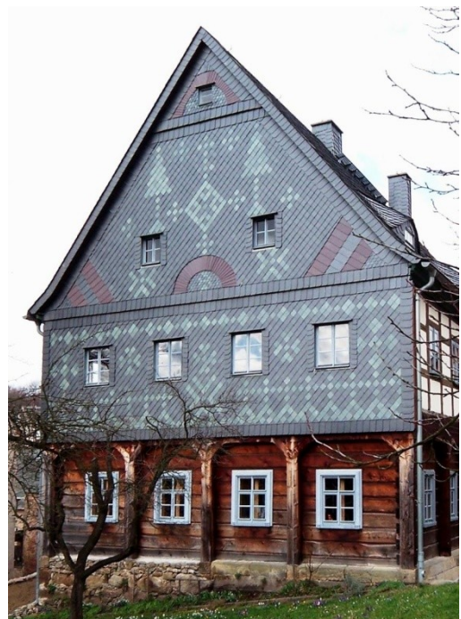
Abb. C-84 links: aufgemaltes freies Muster als Fensterumrahmung (Sohlandl)/ Mitte und rechts: Vergleich der Mustergestaltung mit Kunstplatten (Wehrsdorf) und Naturschiefer (Sebnitz)
