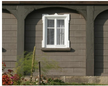
Abb. C-74 Vertäfelung der Blockstube im "Mauerwerksverband" (Bertsdorf)
