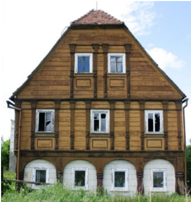
Abb. C-76 Vertäfelung der Obergeschosse (profilierter Umgebinderstander unverkleidet): links: Eibau (+) / Mitte: Oderwitz/ rechts: Leutersdorf
