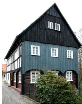
Abb. C-68 zwiebelförmig geschnittene Friesen, auch unter dem Fenster (Obercunnersd.)
