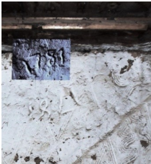
Abb. C-112: links: „1781“: auf dem Kopf (?) stehender Bauzeitvermerk, bei der Präsentation als Foto dazu geheftet /Mitte und rechts: Kamm- oder Finngemuster im Lehmverstrich, gekalkt
