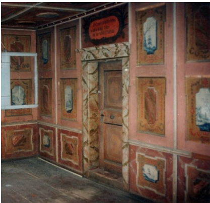
Abb. C-107 Kassetten bemalt im Faktorenhaus / Abbau junger Verkleidungen durch den neuen Hauseigentümer: sogar Schiebeläden (mundartlich „Ritschel“) kommen zum Vorschein!
