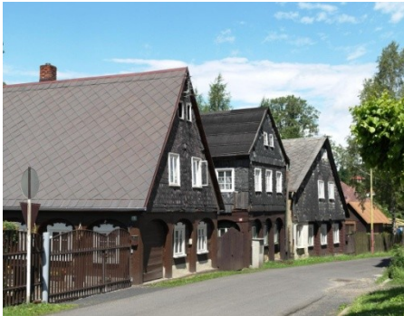
Abb. C-82 links: Schieferwandbehänge an einer Häusergruppe in Šluknov/ rechts: Schieferwandbehänge als wesentlich prägendes Element des Ortsbildes von Obercunnersdorf
