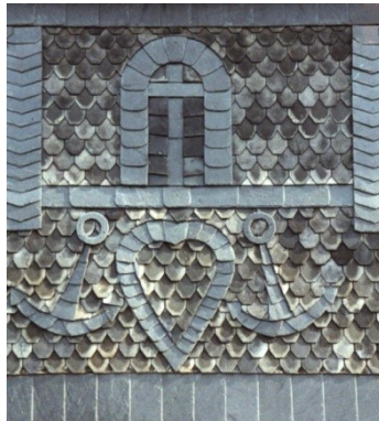
Abb. C-85 Wabenschablonendeckung mit 1/9tel Aufhellung durch weiße Kunststoffschablonen/ Mitte: Kreuz, Herz und Anker in einem Wabenbehang/ rechts: Schuppenschablonendeckung (Zeichnung: BWB Manuskript Neuauflage, Vojtisek)
