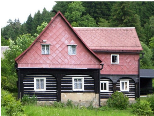
Abb. C-87 links: „Eternit“-Behang aus großformatigen Platten mit Anstrich (Vlčí hora)/ rechts: grobes Erscheinungsbild durch großformatige „Eternit“-Platten
