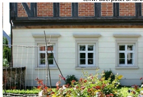
Putzgliederung in Jestřebice teilw. überputzt u. farblich gefasst
