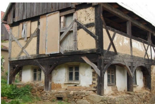
Abb. C-62 unter dem Putz verborgen: zugemauerte Blockstube und Reste der Umgebinderkonstruktion in Rammenau
