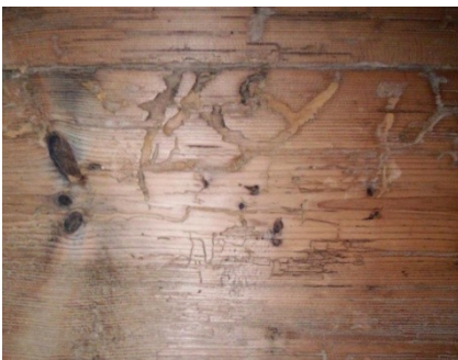
Abb. C-108 Fraßgänge von Holzschädlingen
