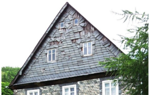
Abb. C-86 links: altdeutscher Behang in Weifa/ Mitte und rechts: Rechteckschablonendeckungen in Neukirch/L. und Vlčí hora
