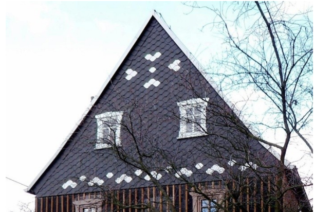
Abb. C-93 Vergleich zwischen einem regionaltypischen traditionellen Schieferbehang und einem jüngst ausgeführten Giebelbehang
