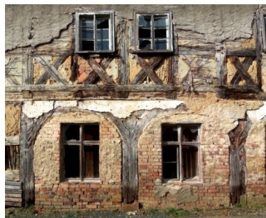
Abb. C-62 unter dem Putz verborgen: zugemauerte Blockstube und Reste der Umgebinderkonstruktion in Rammenau
