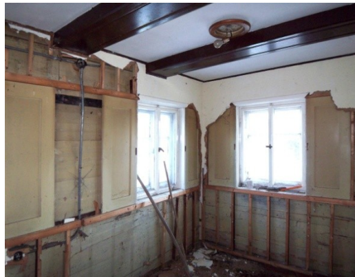
Abb. C-107 Kassetten bemalt im Faktorenhaus / Abbau junger Verkleidungen durch den neuen Hauseigentümer: sogar Schiebeläden (mundartlich „Ritschel“) kommen zum Vorschein!
