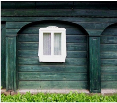
Abb. C-73 Verbretterung von Block, Spannriegel und Knaggen, Ständervertäfelung ( Vlčí hora)
