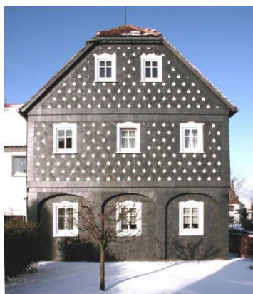
Abb. C-87 links: „Eternit“-Behang aus großformatigen Platten mit Anstrich (Vlčí hora)/ rechts: grobes Erscheinungsbild durch großformatige „Eternit“-Platten
