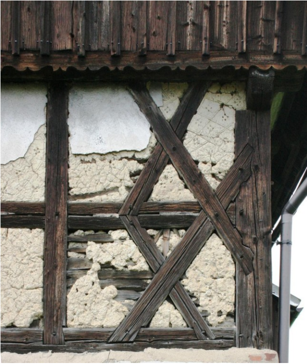
Abb. C-59 Strohlehm auf liegend eingebrachten Holzstaken, Kammuster, Kalkputzreste, (Karpniki, PL)
