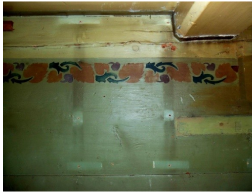
Abb. C-106 „Bierlasur“: Mischung aus abgestandenem Bier und Pigmenten / Ölfarbanstrich mit Musterkante, verschmutzt / Holzkassettenverkleidung im Bauernhaus
