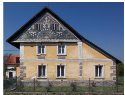
Putzgliederung in Jestřebice teilw. überputzt u. farblich gefasst
