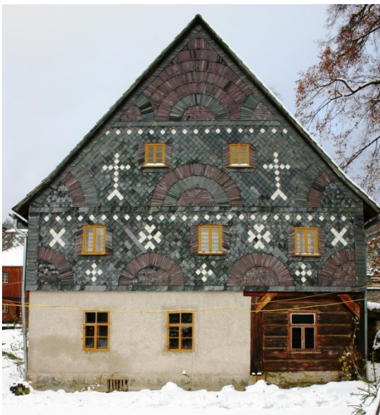
Abb. C-90 in Eigenleistung aus Altmaterial wiederhergestellt
