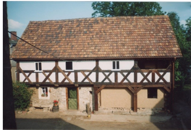
Abb. C-64 Blockstube in Waditz mit Altholz wieder errichtet (Foto: Fa. Klippel) / Stubenverputz anschließend wieder hergestellt (Foto: A. Matthes)
