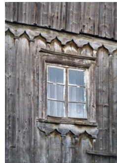
Abb. C-68 zwiebelförmig geschnittene Friesen, auch unter dem Fenster (Obercunnersd.)
