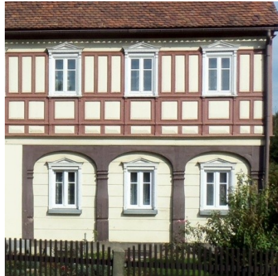
Abb. C-76 Vertäfelung der Obergeschosse (profilierter Umgebinderstander unverkleidet): links: Eibau (+) / Mitte: Oderwitz/ rechts: Leutersdorf
