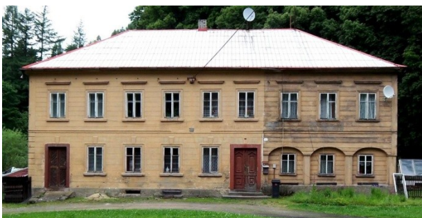
Abb. C-54 Kellenrückenputz, Granitgewände / Putzbänder in Malá Skála
