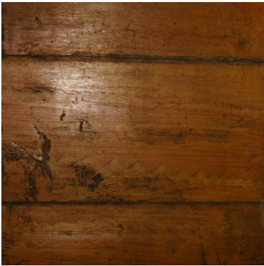
Abb. C-106 „Bierlasur“: Mischung aus abgestandenem Bier und Pigmenten / Ölfarbanstrich mit Musterkante, verschmutzt / Holzkassettenverkleidung im Bauernhaus
