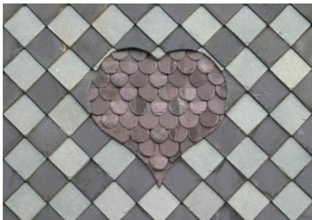
Abb. C-83 mit „weißem“ Naturschiefer häufig aufgehellter Behang, Herz aus roten Schuppenschablonen (Berthelsdorf)
