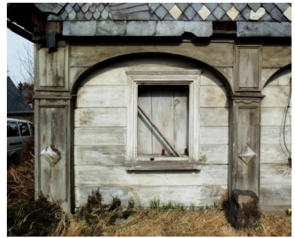
Abb. C-75 Verschalung der Blockstube, Vertäfelung der Umgebinderkonstruktion (Neugersdorf)
