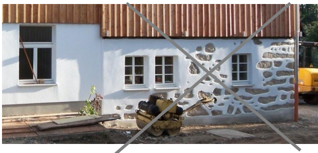
Abb. C-58 Massivteilputz eines Umgebendehauses (Niederconnersdorf)
