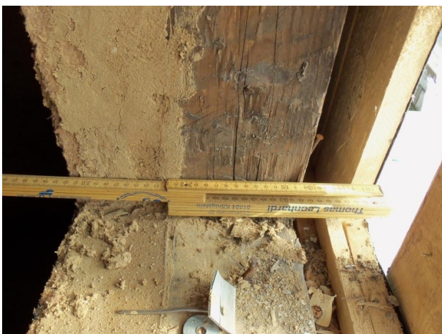
Abb. C-114: 8 cm dicke verputzbare Holzweichfaserplatte, mit Lehm angemörtelt als Innendämmung
