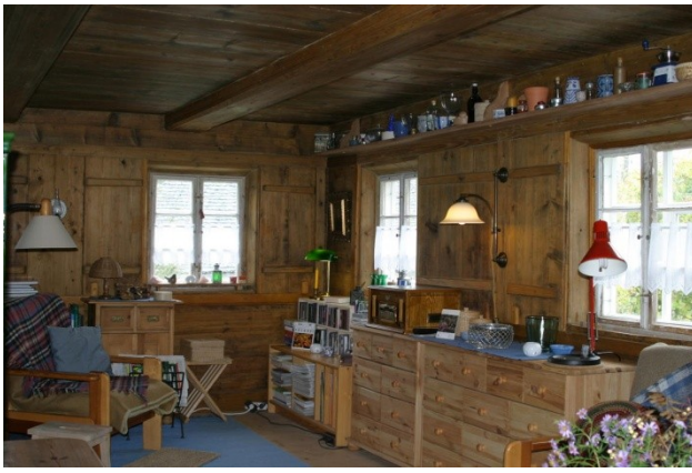
Abb. C-109 wieder hergestellte Holz­sichtigkeit an Wand und Decke und Erneuerung des hellen Anstriches
