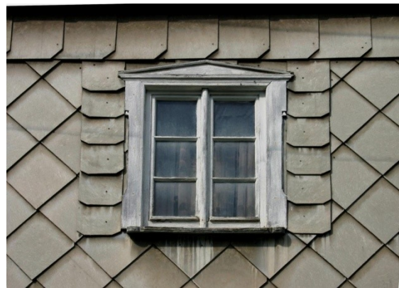
Abb. C-87 links: „Eternit“-Behang aus großformatigen Platten mit Anstrich (Vlčí hora)/ rechts: grobes Erscheinungsbild durch großformatige „Eternit“-Platten
