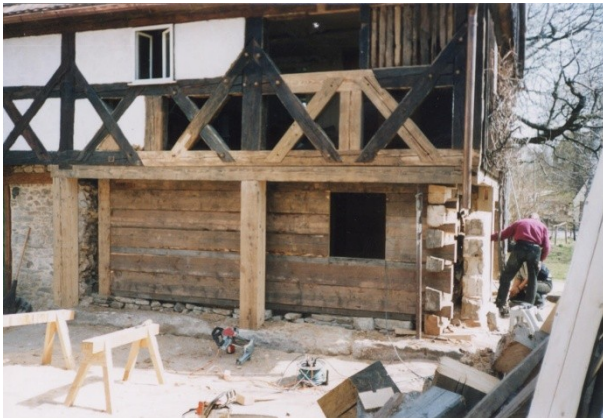
Abb. C-64 Blockstube in Waditz mit Altholz wieder errichtet (Foto: Fa. Klippel) / Stubenverputz anschließend wieder hergestellt (Foto: A. Matthes)
