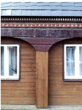
Abb. C-81links: Reste eines vertäfelten Umgebendes mit Fries aus Zahnschnitt, kleinen Diamantquadrern, Flechtband mit Blüten bei unangemessen reparierter Umgebendeständer- und Stubenverkleidung / Mitte: Das Haus ist zur Kiste verkommen./ rechts: leblose neue Schalung
