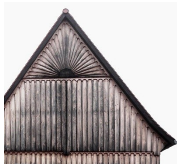
Abb. C-67 OL-Verschlag: Frieze rund geschnitten, Giebelsonne (Ruppersdorf)
