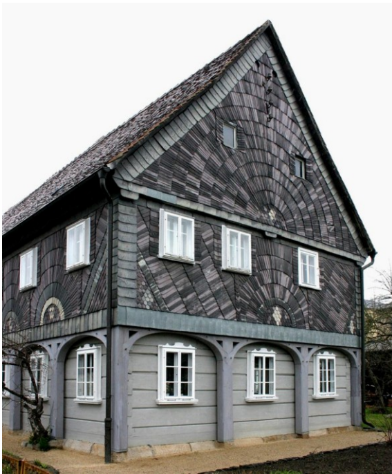
Abb. C-92 instand gesetzte Schieferbehänge in Großschönau (links) und Lipova (rechts)
